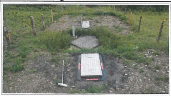
La réfection des dispositifs d'assainissement collectif des hameaux du Peuch, de Bezenchat et de la Brugère est pour l'heure terminée. Si pour la station de la Brugère il s'agissait d'une simple réhabilitation du système existant avec intégration d'un dégrilleur, pour les deux autres stations, les travaux consistaient à créer une nouvelle unité de traitement utilisant un système de filtre biologique : le roseau.
